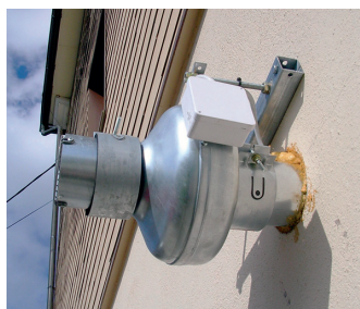
Un ventilateur situé à l'extérieur permet de créer une légère dépression sous la dalle
