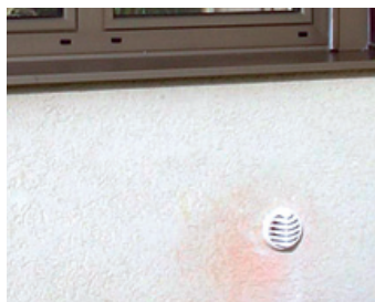
Un apport contrôlé d'air frais crée une légère surpression dans le local / le bâtiment (vues intérieure et extérieure)
