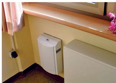
Un apport contrôlé d'air frais crée une légère surpression dans le local / le bâtiment (vues intérieure et extérieure)
