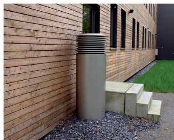
Prise d'air d'une installation mécanique d'apport d'air frais
