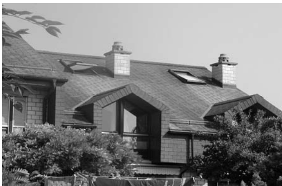
Tuiles en fibrociment, photo IST
