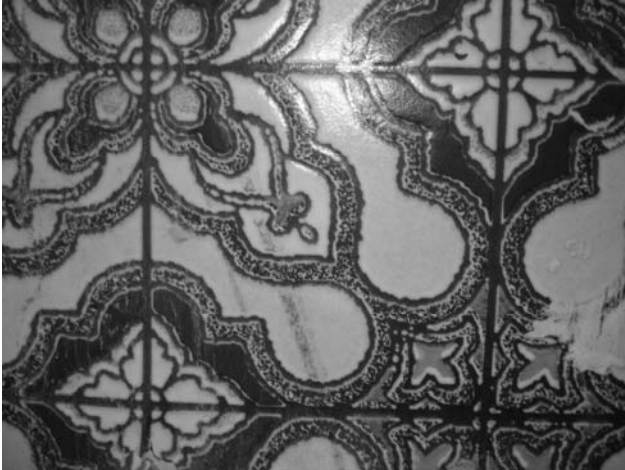
Revêtement de sol à trois couches, dont la couche inférieure est composée d'un carton d'amiante, photo Carbotech SA
