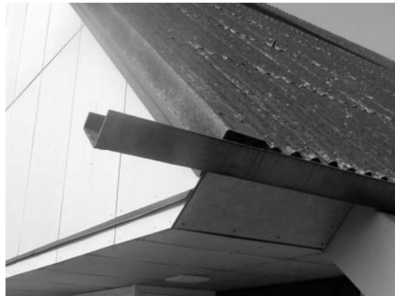
Toiture ondulée en fibrociment, photo IST
