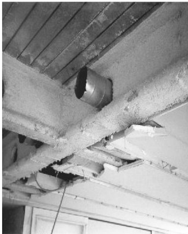
Flocage d'une structure métallique, photo IST
