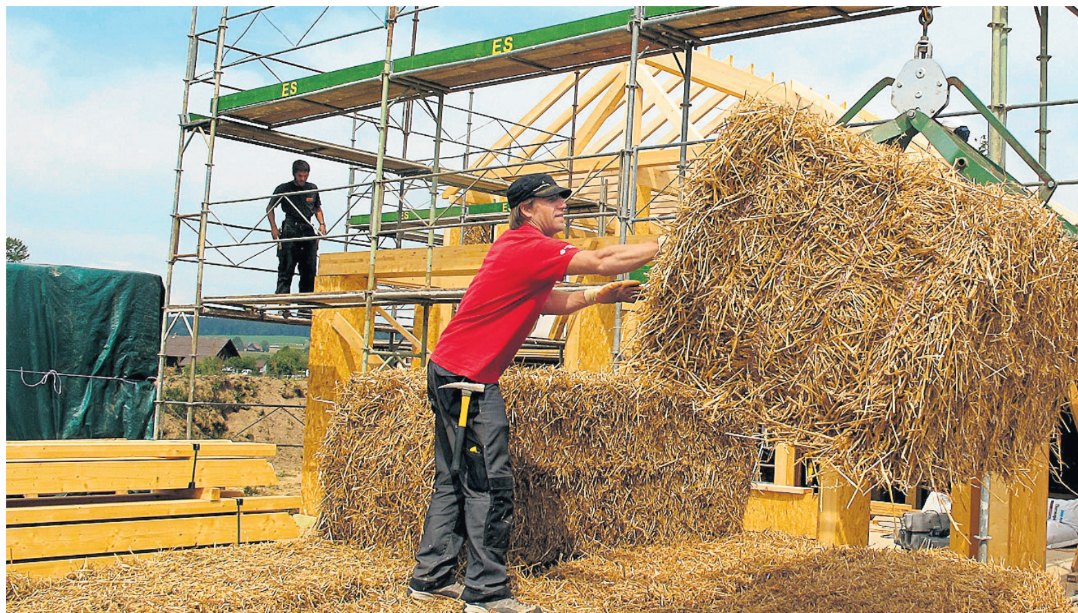
Aux Cullayes (VD), d'énormes bottes de paille porteront la maison dessinée par le bureau d'architectes Pont12. Chacune d'elles pèse environ 250 kg.
