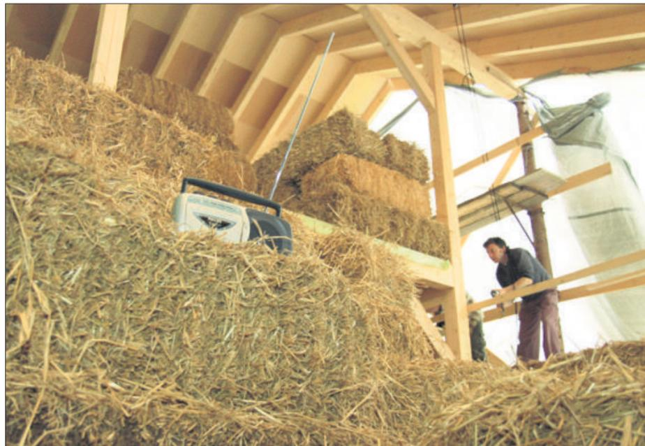
**BOTTES** Les «briques» de paille qui constituent le matériau pour les murs sont entreposées sous le toit, abritées de la pluie par des bâches.
