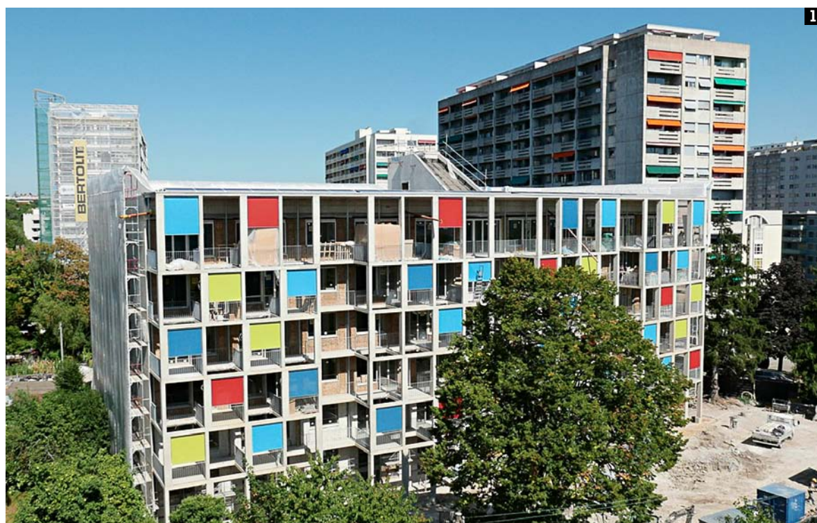
1. Le bâtiment compte 5 étages et 38 logements. 2. L'architecte Stéphane Fuchs en est à son troisième immeuble coopératif en paille dans le canton de Genève. 3. Deux mille bottes de paille isolent les façades nord et sud. 4. Un potager collectif prendra place sur la toiture. 5. Les habitants ont mis la main à la paille lors de ce chantier participatif.
