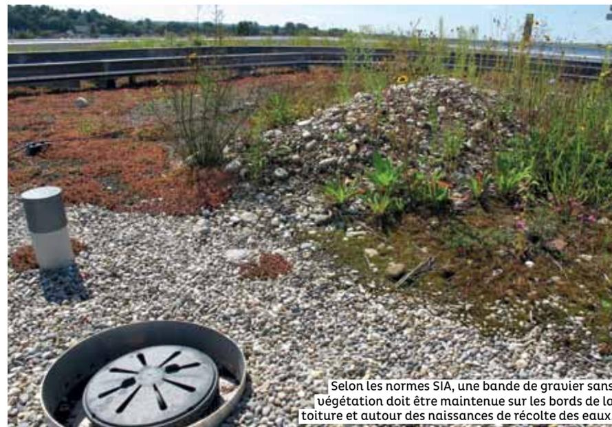
Selon les normes SIA, une bande de gravier sans végétation doit être maintenue sur les bords de la toiture et autour des naissances de récolte des eaux.
