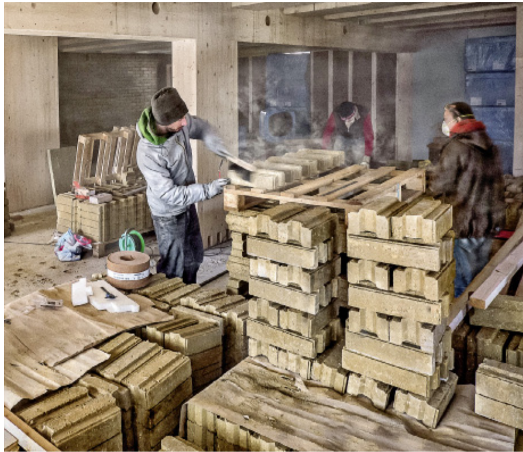
Les futurs habitants participent à la construction des murs en terre crue. Pierres sèches, tavillons, bois et paille ont aussi trouvé leur place dans cet immeuble moderne qui vise les plus hauts standards écologiques et énergétiques.
