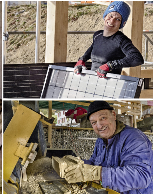
Les futurs habitants participent à la construction des murs en terre crue. Pierres sèches, tavillons, bois et paille ont aussi trouvé leur place dans cet immeuble moderne qui vise les plus hauts standards écologiques et énergétiques.
